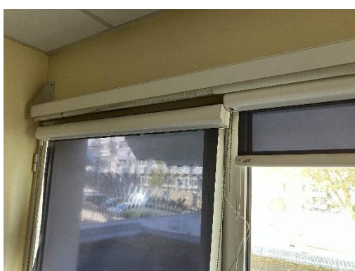
Entrée d'air en partie bouchée par store
