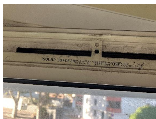
Absence module entrée d'air
